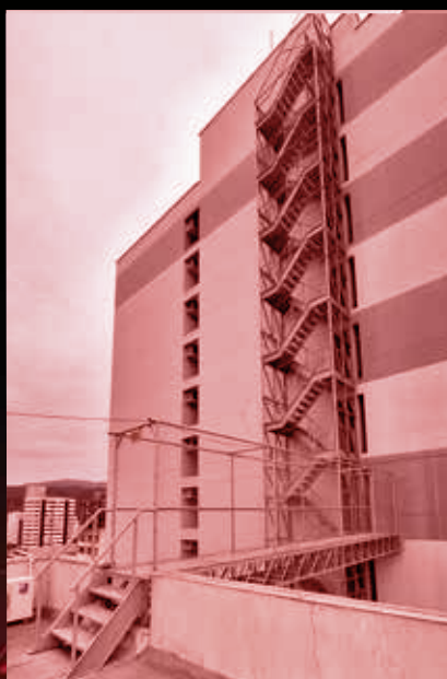
Passarela que liga os Edifícios Catarinense e Albor
